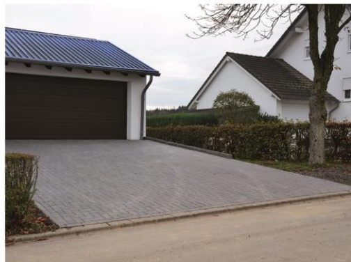
Tiefbau und Außenanlagen
